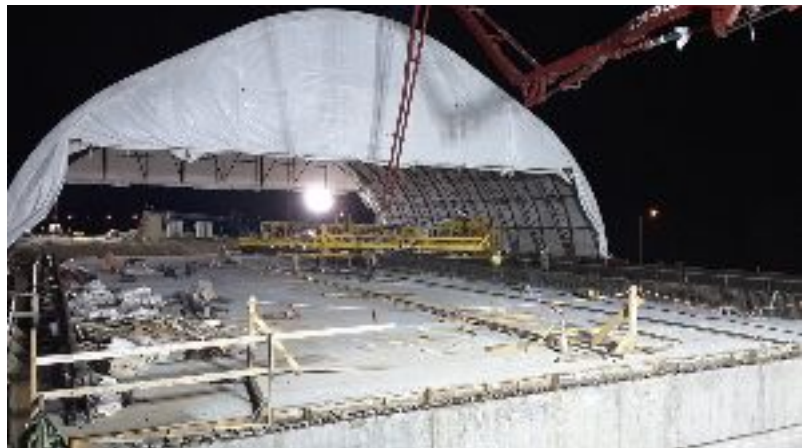
Night Pour at Structure 4 over Raleigh Street
