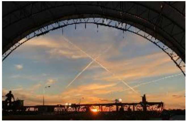
Sunset at the Start of a Deck Pour
