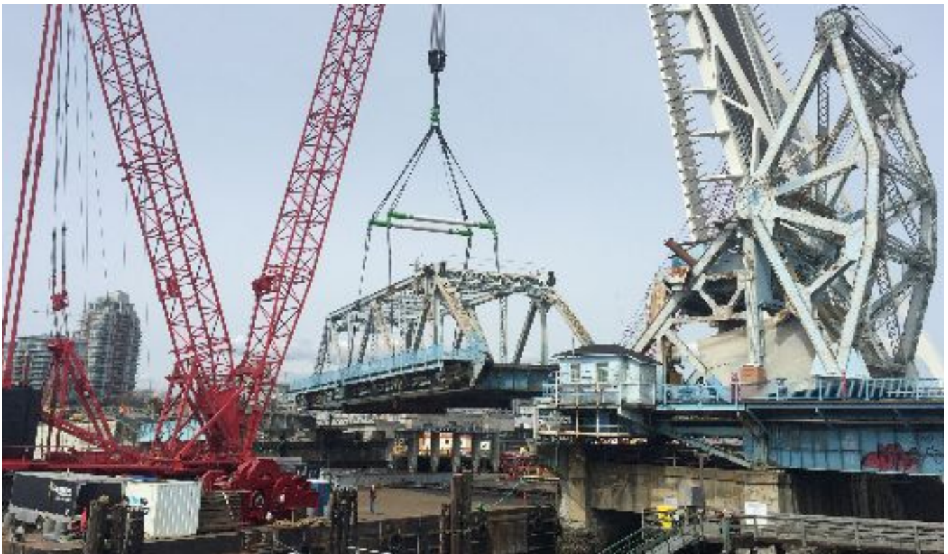
Demolition of «Old Blue»
