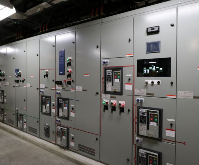
Intelligent Switchgear
