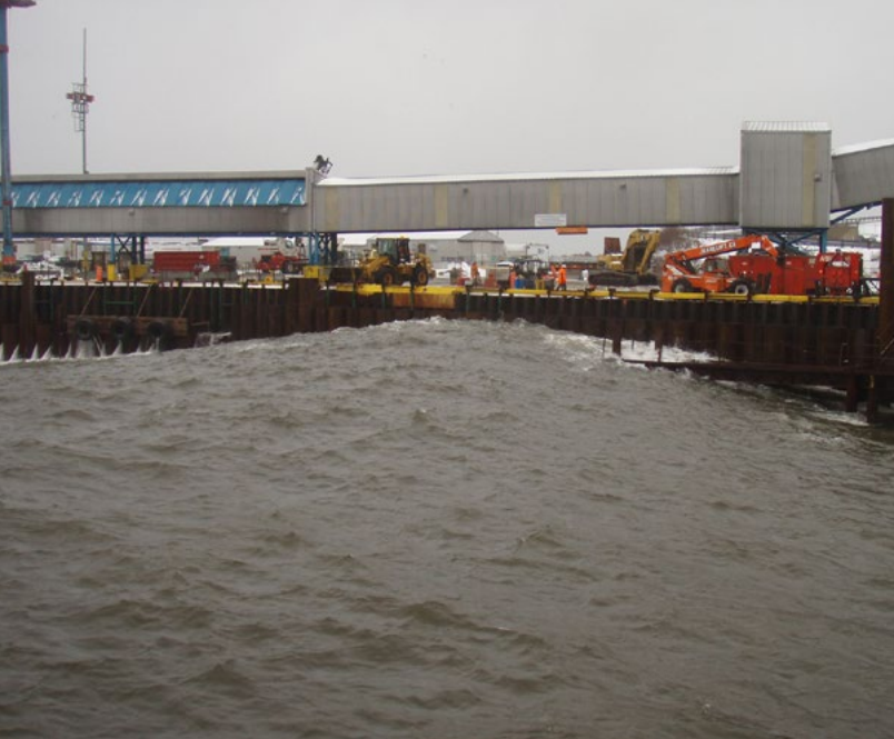
Conditions de tempête extrêmes observées dans l'aire de construction du brise-lame, anse du Moulin, Baie-Comeau
