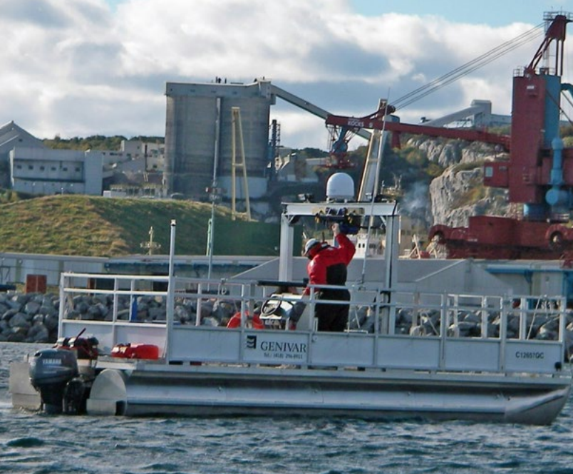
Campagne de carottage au vibrocarottier dans l'anse du Moulin
