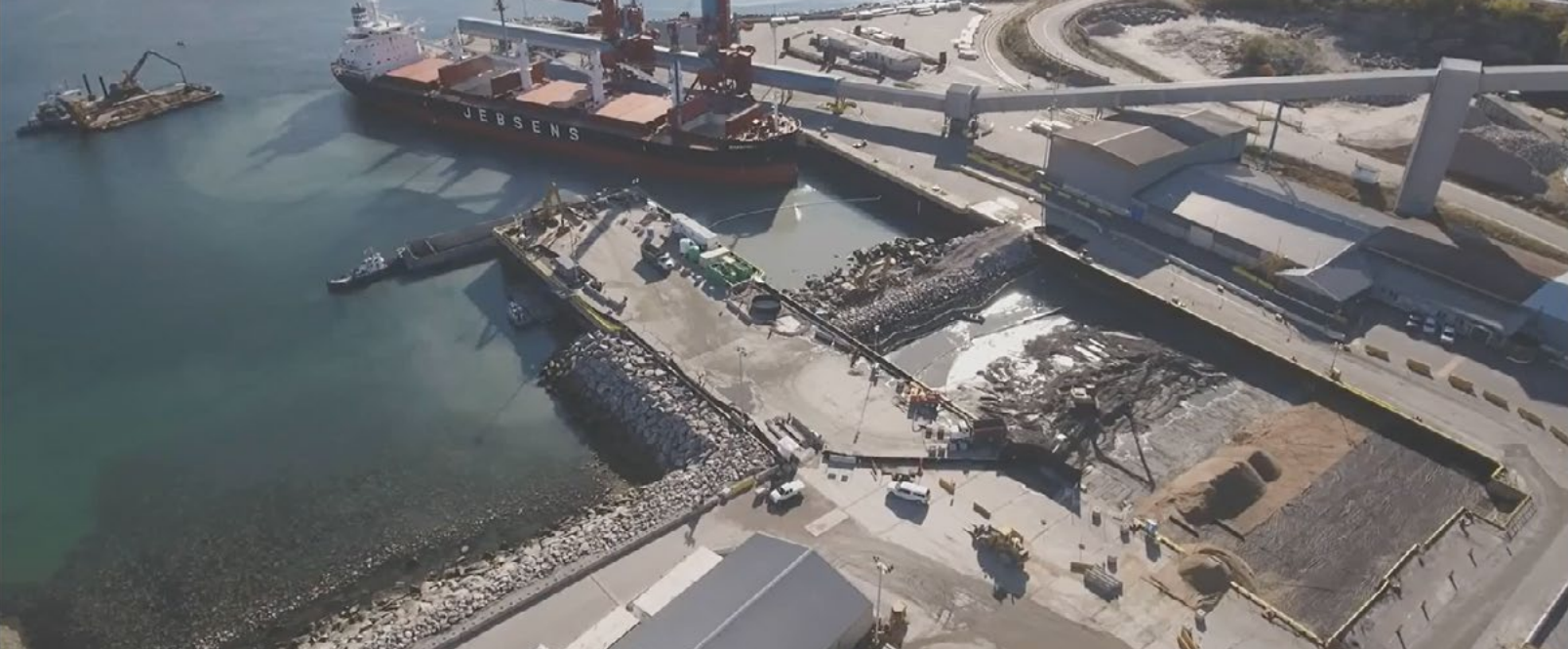
Vue d'ensemble du chantier.
