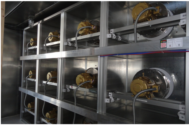
Fan Array in Air Handling Unit
