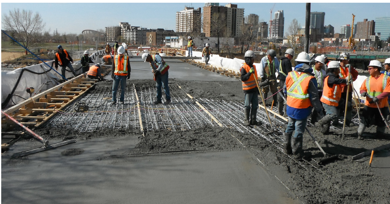
Initial infill concrete pour
