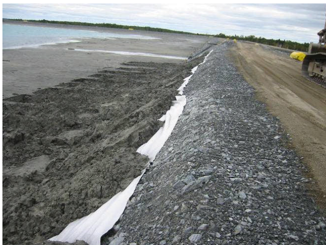
Figure 13: Rehaussement sur les résidus - construction- géotextile et résidus en amont
