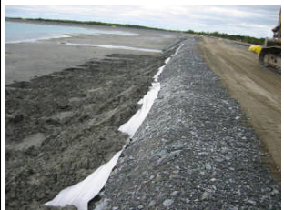
Figure 2: Vue de la construction des rehaussements amont
