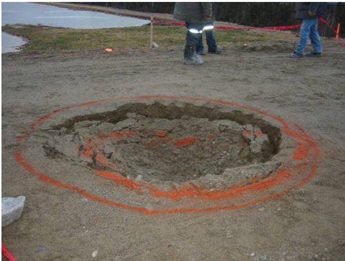
Figure 6: Dépression de surface indicative du développement d'une cavité dans la digue 1
