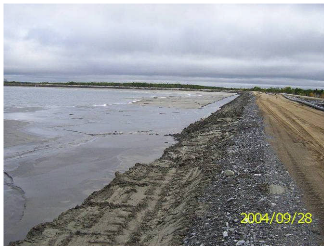
Figure 13: Rehaussement sur les résidus - construction- géotextile et résidus en amont
