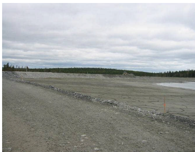
Figure 13: Rehaussement sur les résidus - construction- géotextile et résidus en amont
