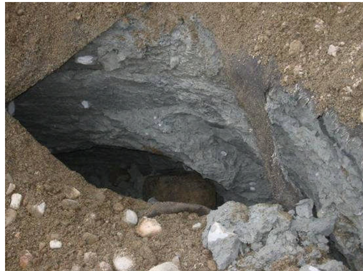
Figure 7: Cavités dans le noyau de la digue suite au développement de gradients excessifs et la migration des matériaux fins dans les matériaux grossiers.
