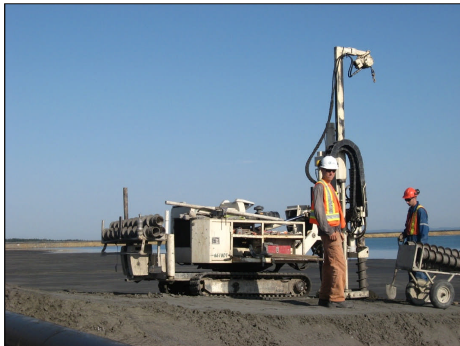
Figure 16: Installation d'un piézomètre électrique en amont du troisième batardeau
