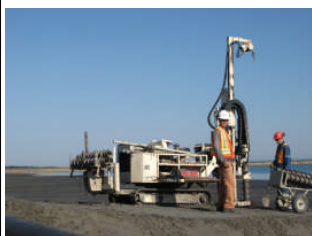
Figure 3: Installation de l'instrumentation sur la surface des résidus pour retro-analyse
