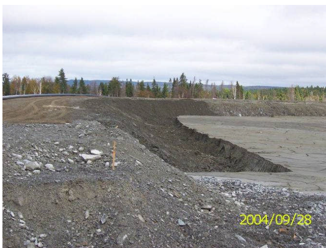
Figure 14: Rehaussement – construction – géotextile et résidus en amont
