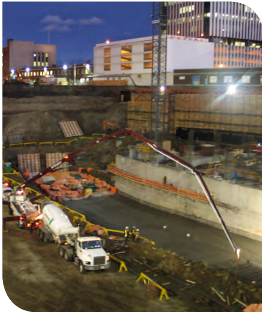
Base slab pour with CN Tower in background
